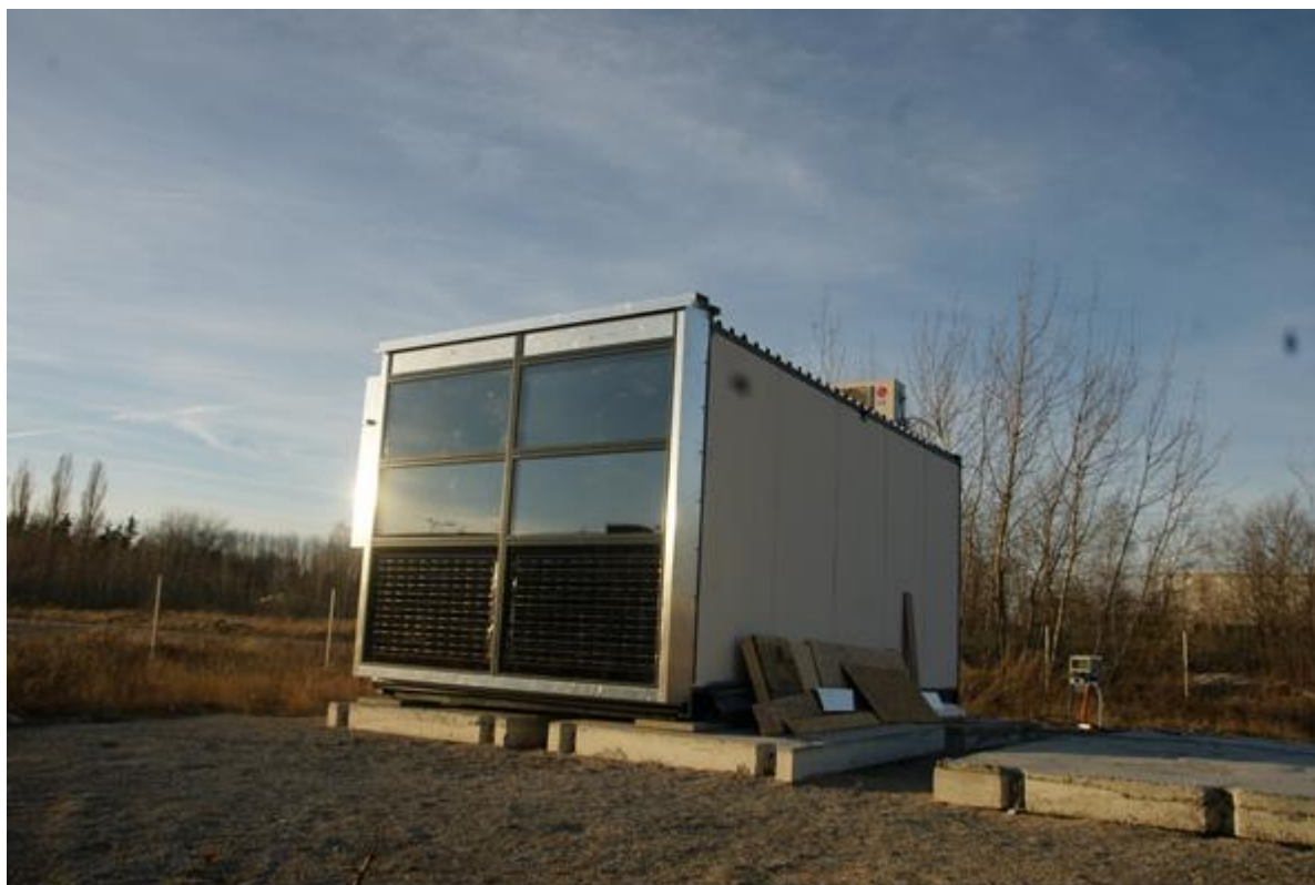
Obrázek 2 Testovací objekt s instalovaným fasádním modulem (FVT kolektor, optické rastry)
